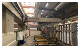
Stanowisko nr 3 spawanie robotem
